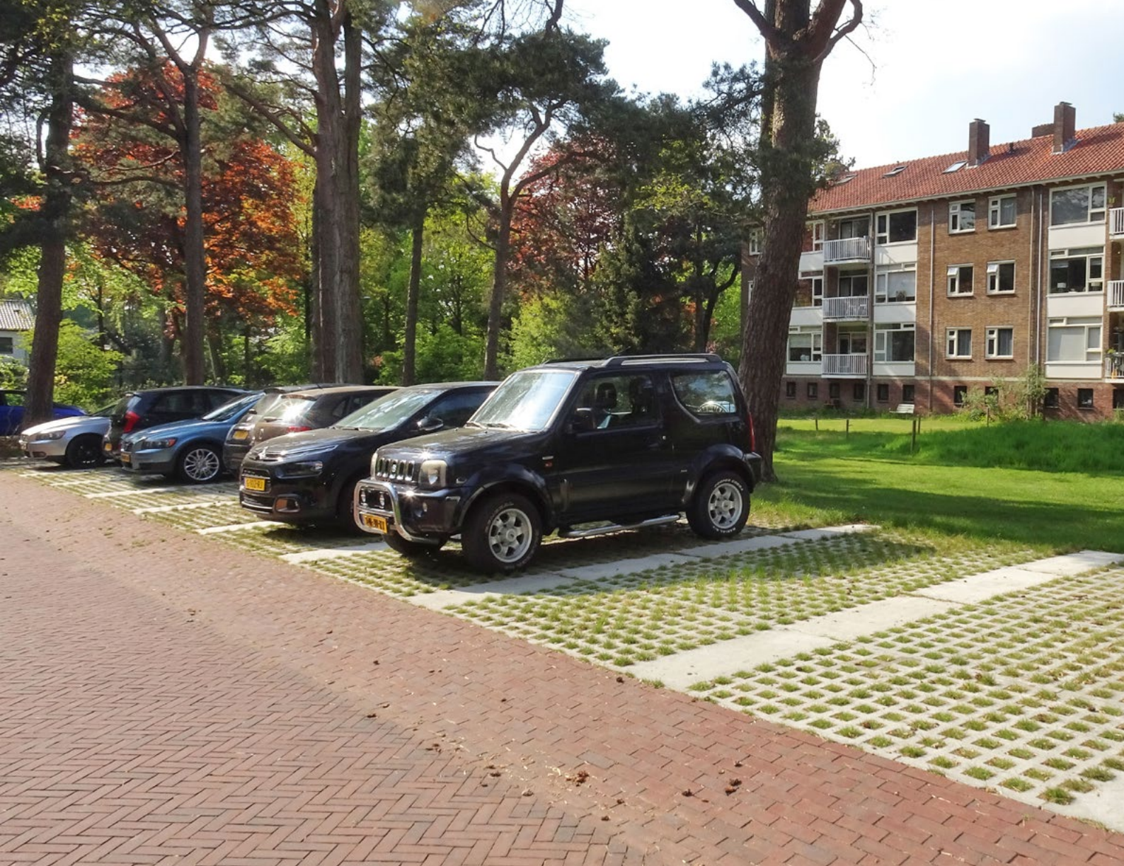
Door een slimme afwisseling van open en gesloten verharding is de straat voor iedereen goed begaanbaar (foto Nanda Sluijsmans).
