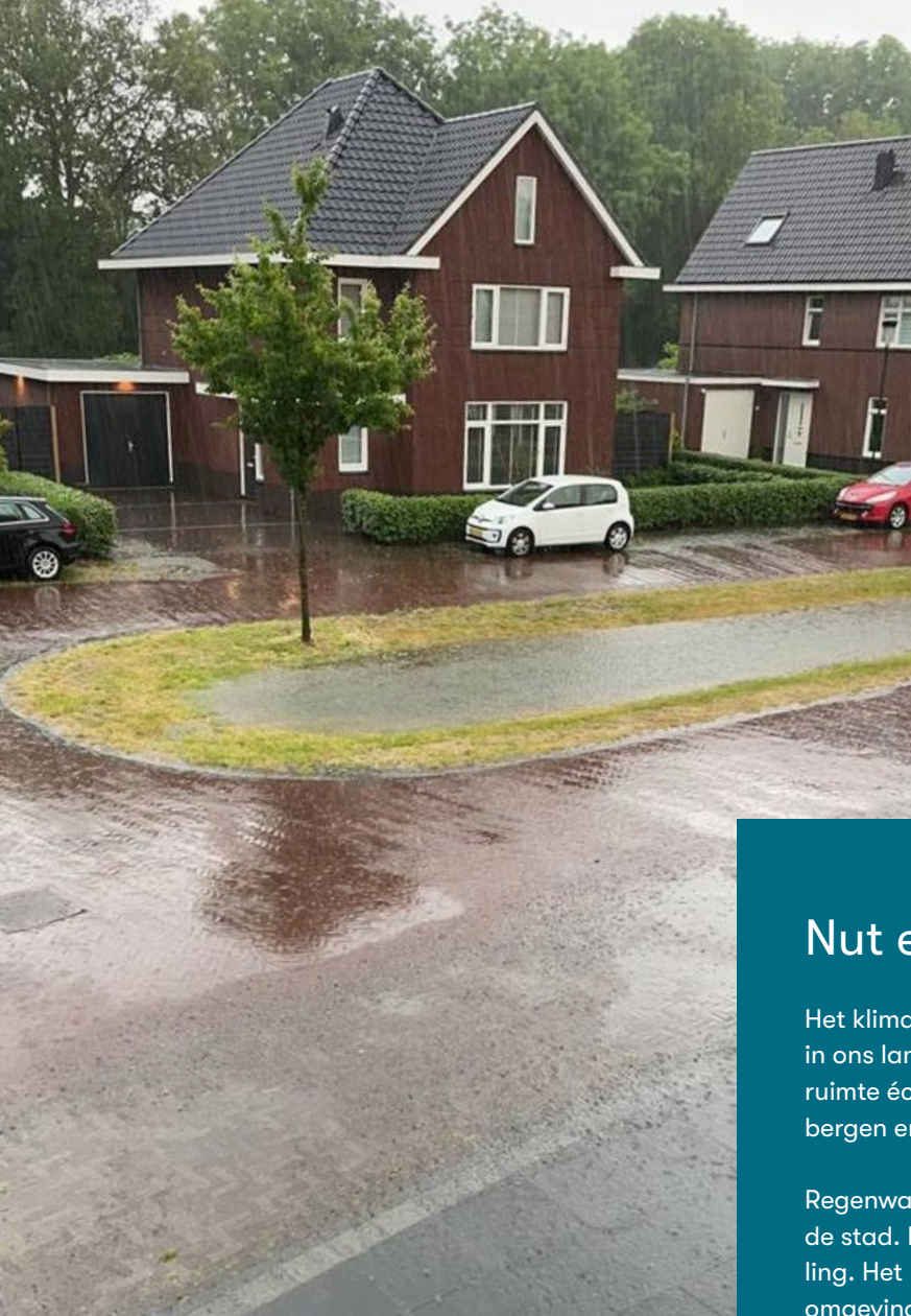
Bovengrondse afvoer van regenwater naar een wadi.
