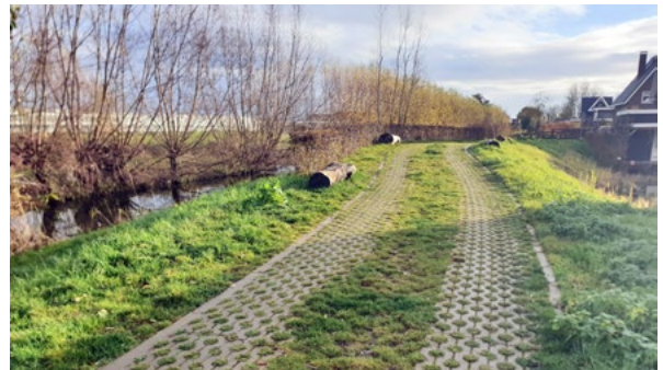
Waterdoorlatende verharding in de wijk Ackerswoude (boven) en karrespoor voor vuilniswagen (onder), beide in Pijnacker (foto's Nanda Sluijsmans).
