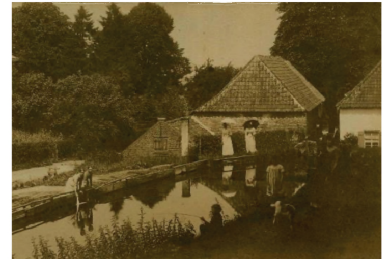
Wasboerderij met spoelput, waarschijnlijk de Elzen. Ca 1890 (bron: provincie Gelderland)
