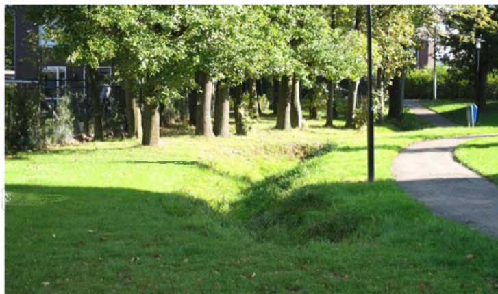
Groene goot kan water afvoeren naar infiltratieveld (Heerlen)
