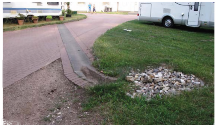
Voorbeeld van zichtbare wateropvang en infiltreren (Eiffel)
