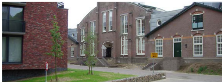
Combinatie kazernegebouwen en appartementen in Limos
