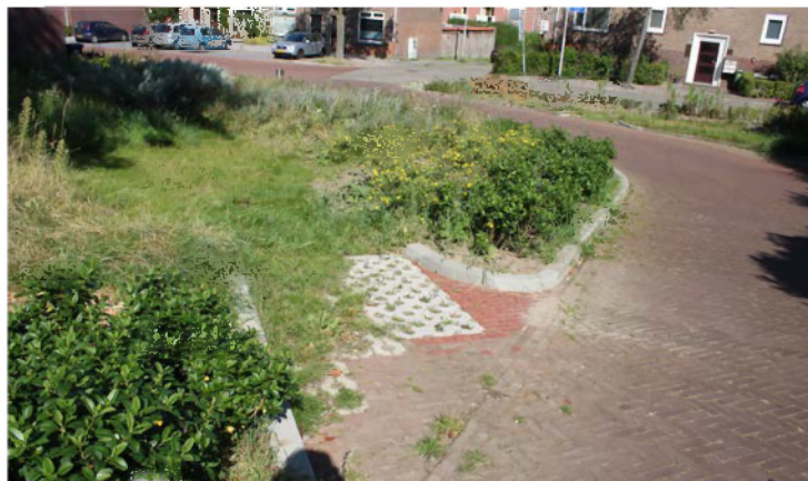
Voorbeeld in de wijk van opvang en infiltreren dwars op de helling (Zilverdenplantsoen)
