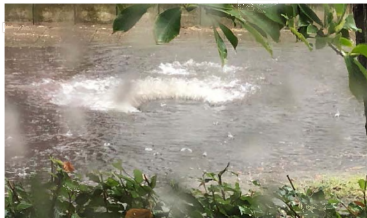
Riool kan toevoer water niet aan en loopt over, Dommer van Poldersveldweg
