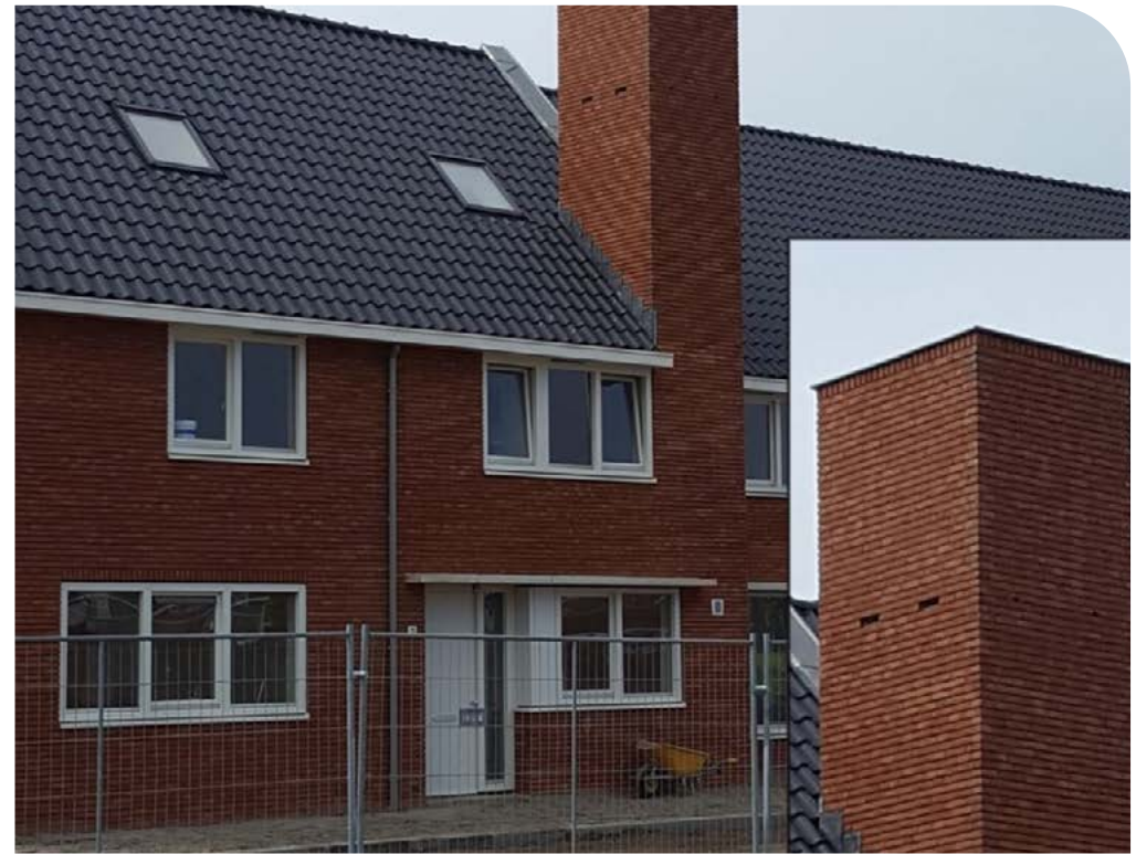
Toegankelijk gemaakte loze ruimte in sierschoorsteen.
