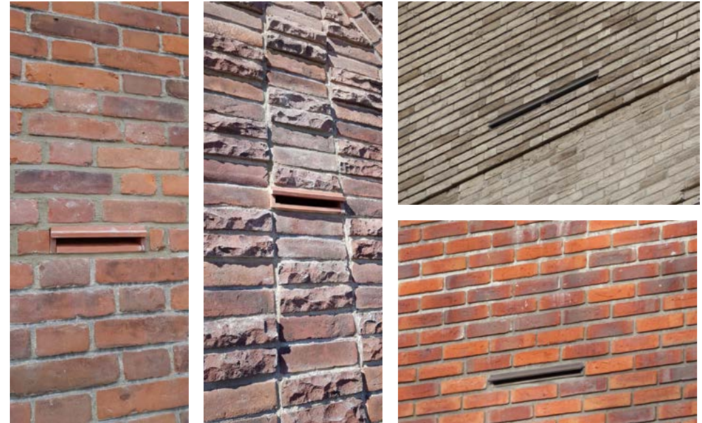
Ingemetselde Grote en Kleine Tichelaar vleermuiskasten in nieuwbouwegevels. Foto's rechts: Erik Korsten.
