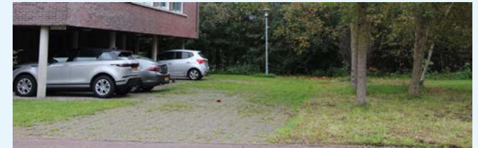
Halfopen verharding voor opritten maakt het mogelijk dat regenwater in de bodem kan wegzakken. Egelshoek, Heiloo.
