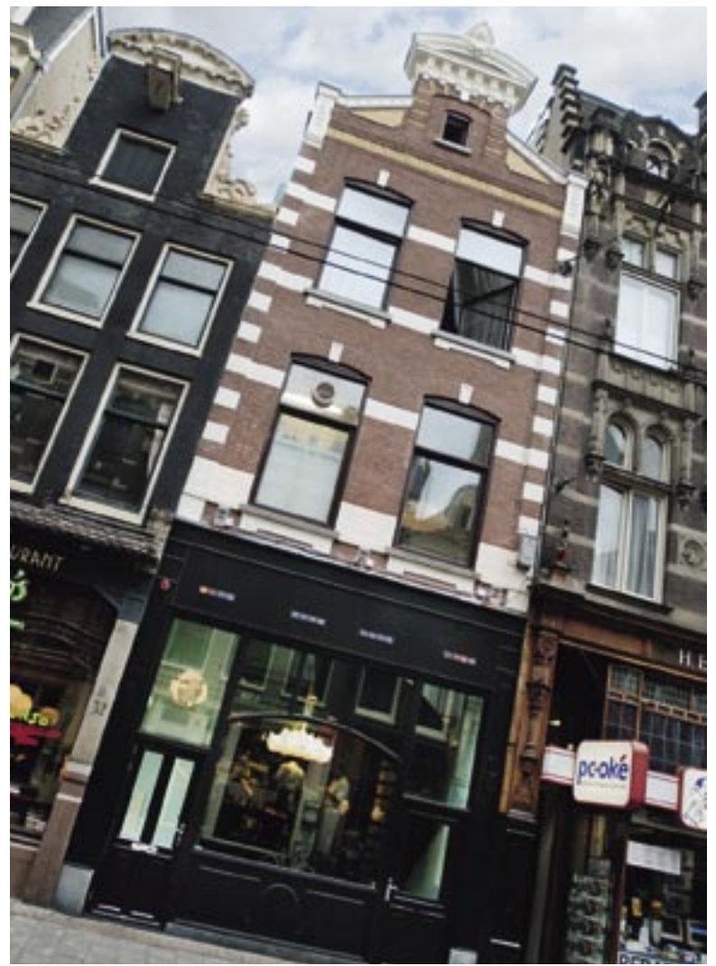
In slechts 9 weken tijd moest het restaurant volledig worden verbouwd.
