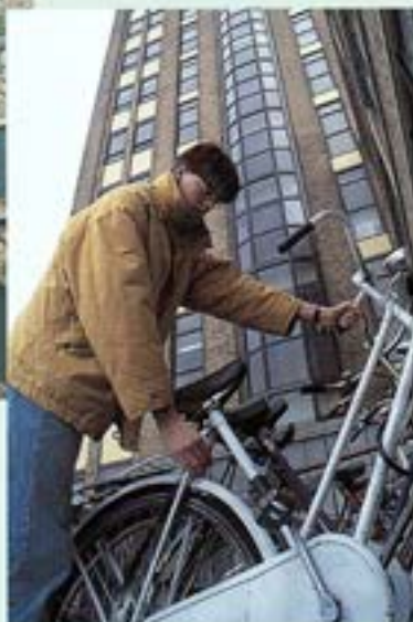
Het economisch verouderde hoofdkantoor van het voormalige GEB (nu onderdeel van Eneco) is omgebouwd tot studentenflat. Er zijn 235 appartementen gerealiseerd.
