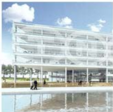
Het GREEN Office in Hoofddorp wordt het eerste CO 2 -emissievrije TNT-kantoor ter wereld. Ontwerp: Architectenbureau Paul de Ruiter.
