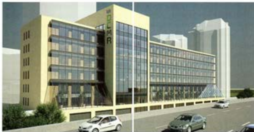
In januari 2010 hoopt de DCMR haar nieuwe pand te betrekken: een opvallend gebouw in Schiedam, tussen de spoorbaan en de A20. Bron: Van den Oever, Zaaijer & Partners architecten Amsterdam.
