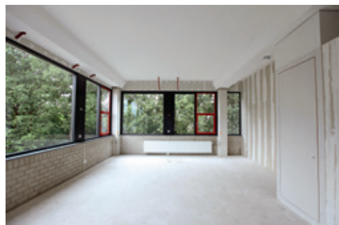
Brinkwal, Nieuwegein. Transformatie van kantoorfunctie naar wonen. Van boven naar beneden: de voormalige kantine, een plattegrond voor de verbouwing en een deel van de verbouwde lunchruimte. (foto's: Rijksdienst voor Ondernemend Nederland en Jutphaas Wonen)
