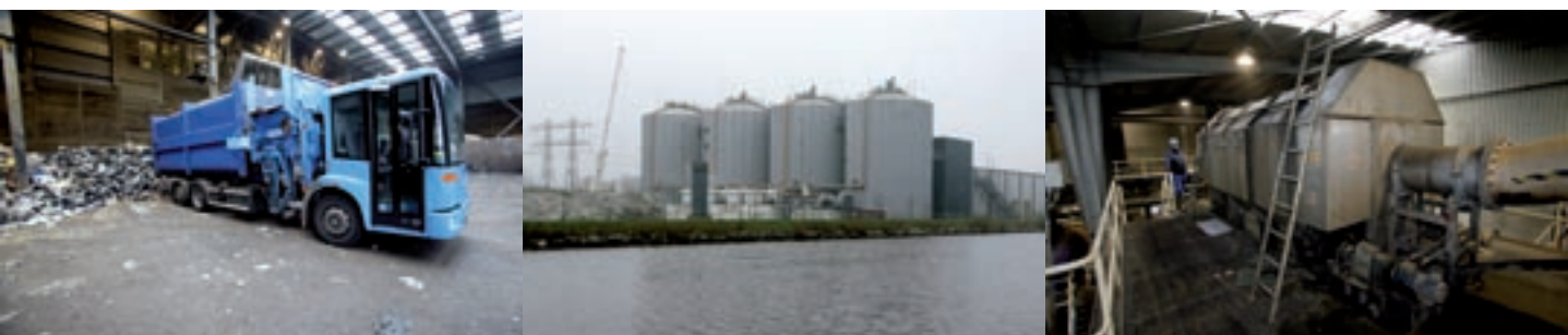
Vergisting van organisch restmateriaal bij afvalverwerkingsbedrijf Vagron in Groningen levert jaarlijks circa 15 miljoen kWh groene stroom.
