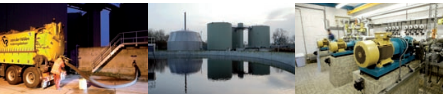
Door vergisting van rioolslib wordt biogas gewonnen, onder andere geschikt als energiebron voor verbrandingsmotoren.
