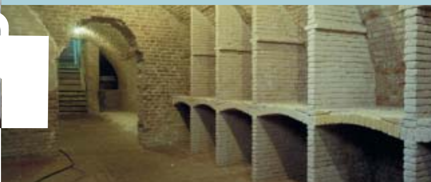
Eén van de gerestaureerde kelders in de Rijnstraat in Arnhem.
