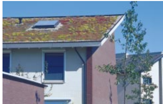
Compacte zonneboiler op een grasdak.
