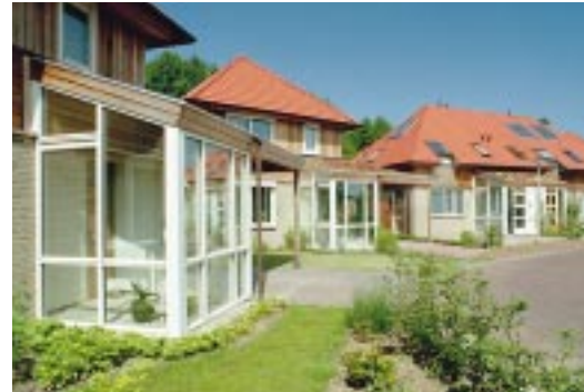
Een serre voor de entree beperkt warmteverliezen en zorgt ervoor dat ventilatielucht door de zon wordt voorverwarmd. Voor de bewoners levert deze serre vooral een aangename entree op. Project: Oikos, Enschede
