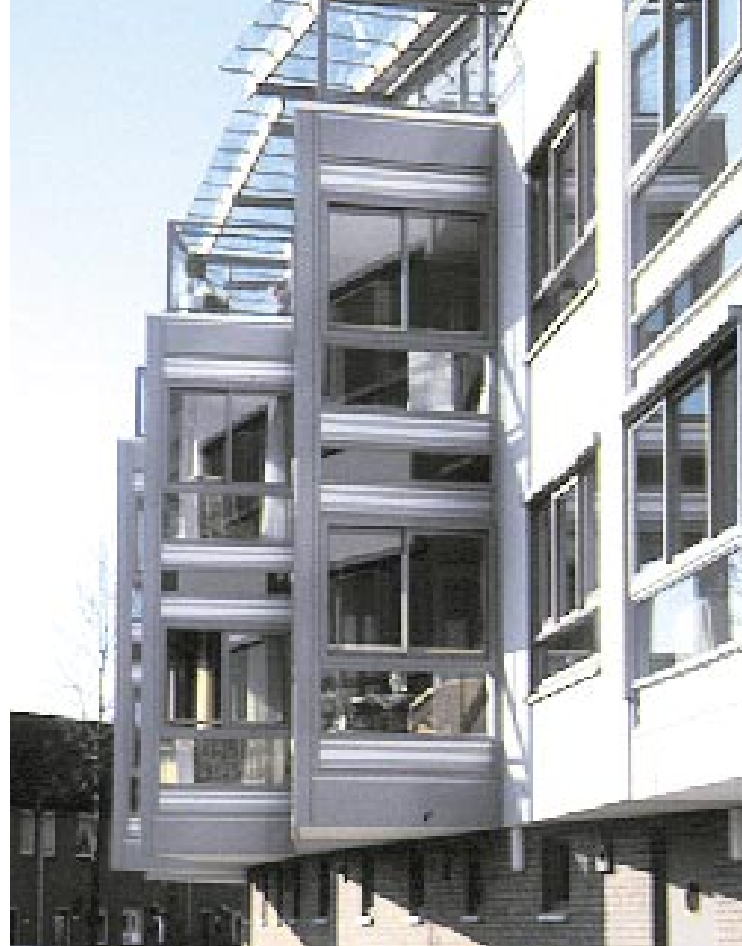
39 appartementen in Dordrecht. Hiervan worden er 22 uitgevoerd met een serre of een loggia. Opdrachtgever Van der Vorm Bouw, Papendrecht. Architect: Franke Architecten bv
