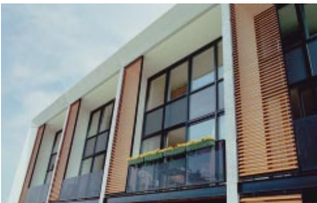
Lamellen houden de hoge zomerzon tegen en laten de lage winterzon door. Project: Zenderpark IJsselstein
