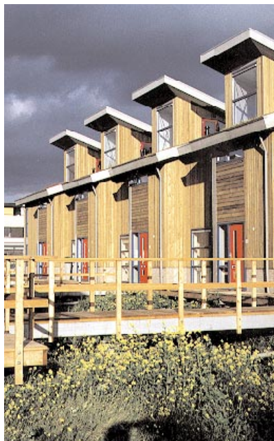
Serre- en steigerwoningen Opdrachtgever: Bouwbedrijf Van Nassau, Roosendaal Architect: Franke Architecten bv
