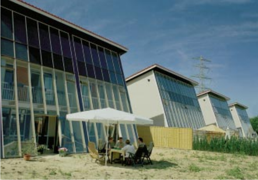
Een tweelaagse serre waarbij het bovenste vlak is ingevuld met zonnepanelen. Project: Carisborg, Heerlen Architect: Renz Pijnenborg
