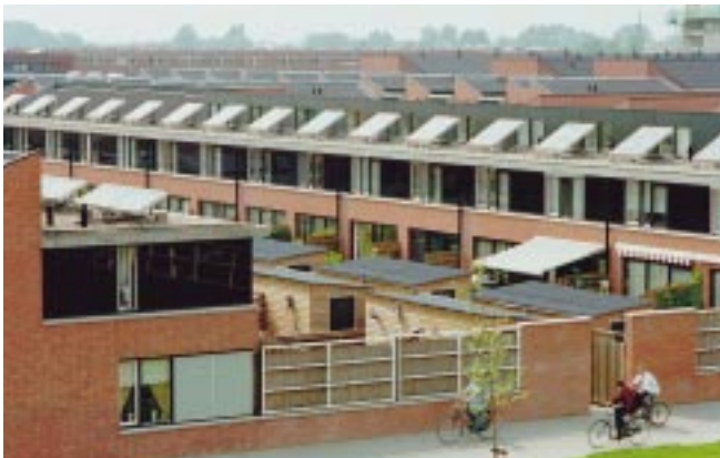
Platdakopstellingen van zonneboilers.
